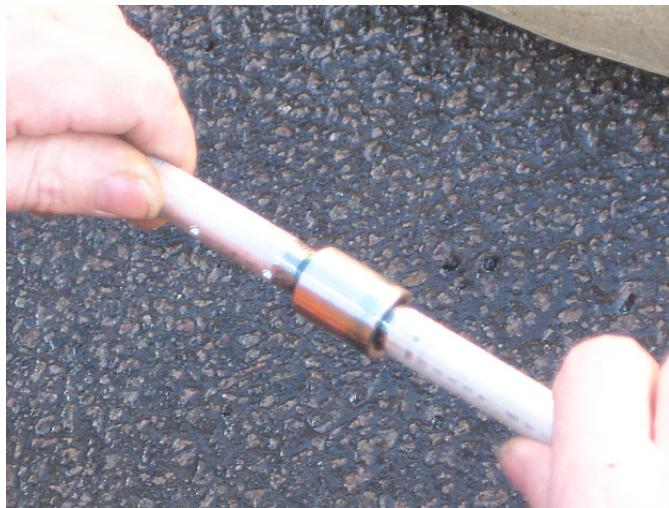
Bild 84. Montering av munstycksröret
