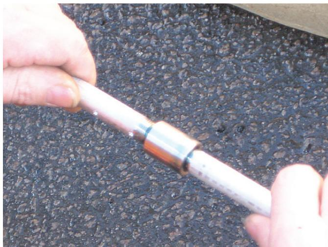
Bild 83. Montering av munstycksröret
