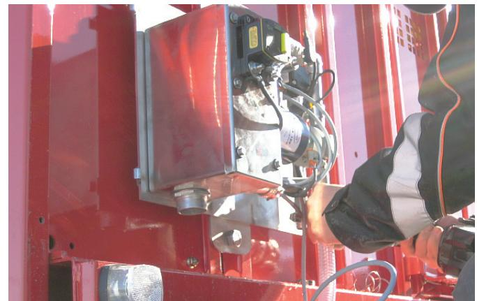
Bild 69. Sugrörens anslutning till pumpens sugsida
