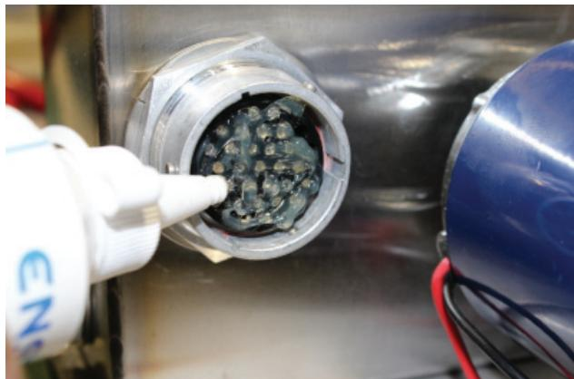
Bild 30. Smörjning av anslutningarna med skyddande medel.
