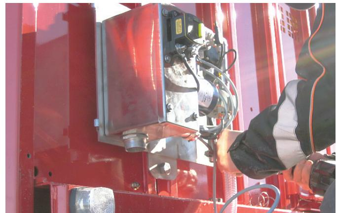
Kuva 69. Imuletken liittäminen pumpun imupuolelle
