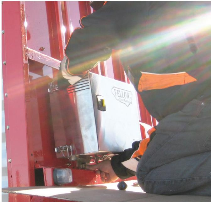
Kuva 62. Pumppukotelon kiinnitys
